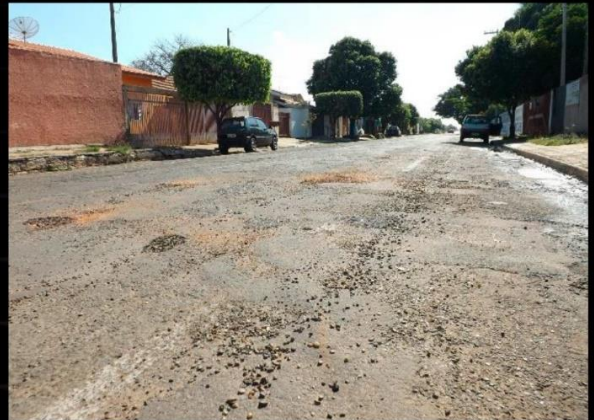
Rua com pedras, cascalhos e objetos pontiagudos que geram arrancamentos na banda de rodagem, principalmente de pneus on road.
